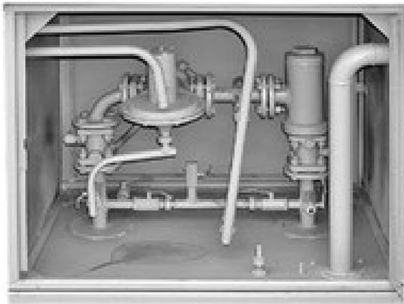
Газорегуляторные пункты ГРПН регуляторами РДУ-32/С1 (РДУ-32/С2, РДУ-32/С3) предназначены для редуцирования природных углеводородных и других неагрессивных газов с высокого и среднего давления на низкое и снабжения газом требуемого давления потребителей.
